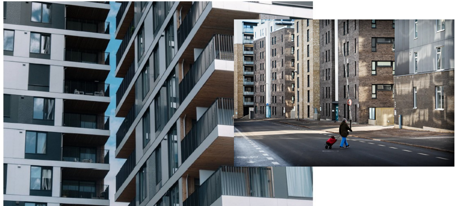
Tetti i toppen: Med en utnyttelsesgrad på 400 prosent plasserer Meierikvartalet seg helt i norgestoppen over mest tettbygde bormiljøer. (Foto: Stine Moldafjel)
