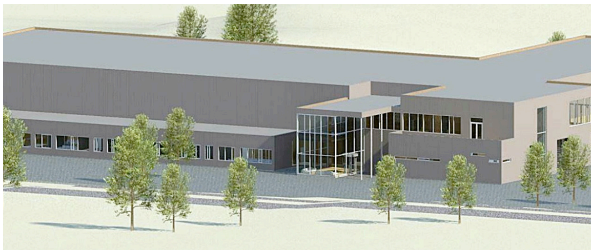
F135 Motordepot på Rygge Flystasjon, 6 500 m2.
